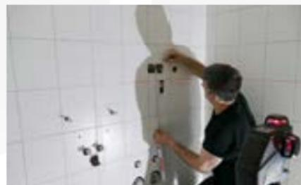
Déterminer toutes les dimensions nécessaires à la découpe des panneaux VIPANEL®.
