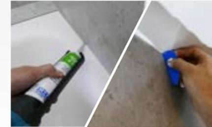
Appliquer du silicone aux pourtours des panneaux pour assurer l'étanchéité. Retirer le surplus de silicone.
