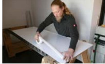
Retirer le film de protection à l'arrière des panneaux. Appliquer l'adhésif double face en mousse qui assurera l'adhésion initiale du panneau.
