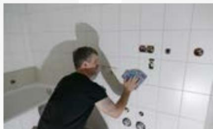
Le support doit être stable, uniforme, sain et sec. Appliquer un primaire sur les supports fortement absorbants tels que les panneaux de fibres de plâtre ou de gypse. Nettoyer le support avec un dégraissant.
