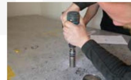
Réaliser les perçages. Les ouvertures pour les raccords peuvent être réalisées avec une scie cloche du diamètre approprié ou avec une scie sauteuse à dents fines.
