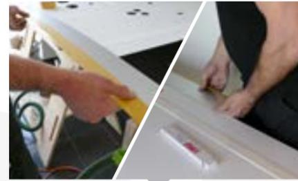
**Pose bord à bord :** afin de garantir une jonction uniforme entre les panneaux il est recommandé de fixer une bande métallique (PM BME 0103001) avec un adhésif double face. A appliquer sur chaque bord de la bande, sur toute la hauteur.
