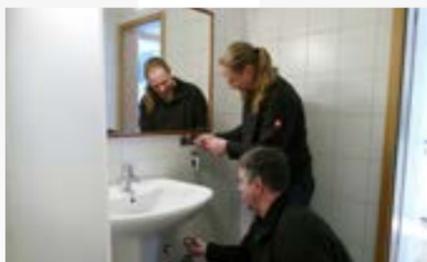
En cas de rénovation, commencer par le démontage (couper les raccords existants et l'arrivée d'eau, les fusibles doivent être éteints).
