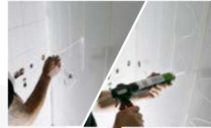
Pour le collage durable des panneaux, appliquer du silicone en cordon à l'arrière du panneau. Compter environ 1 cartouche pour une plaque de 2.55 x 1.5m.
