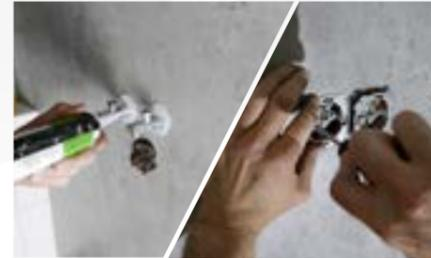
Comblent les ouvertures avec du silicone.
